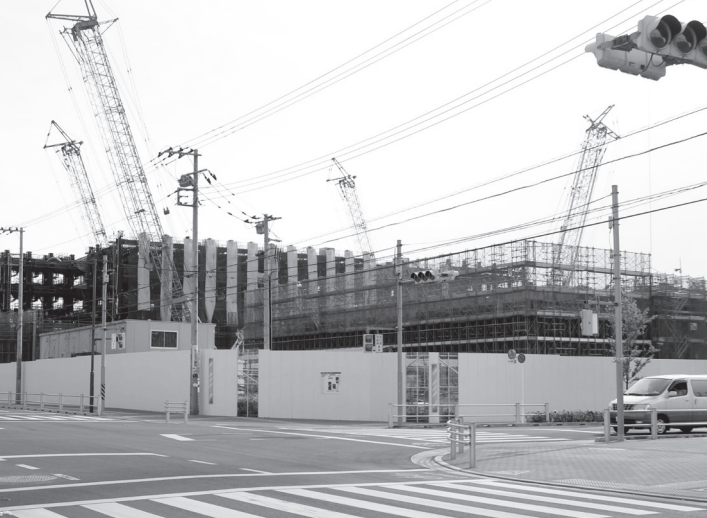
▲ 現在建設中の葛飾キャンパス
