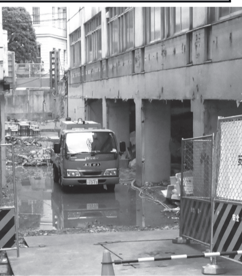
▲6号館の改修工事の写真
